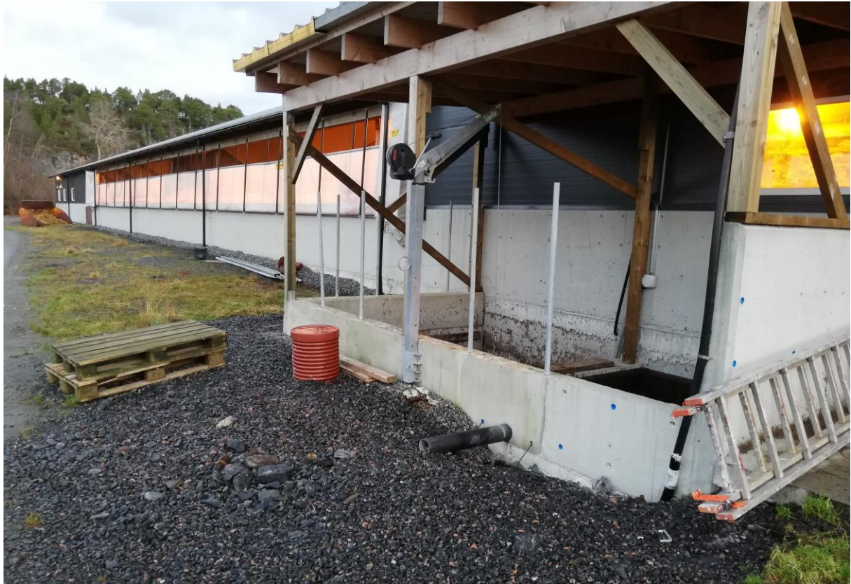
Bilde 6. Storfefjøs på gård 3. Gjødsla lagres i kum før den slippes ned til biogassanlegget. Foto: Lovise Sæter
