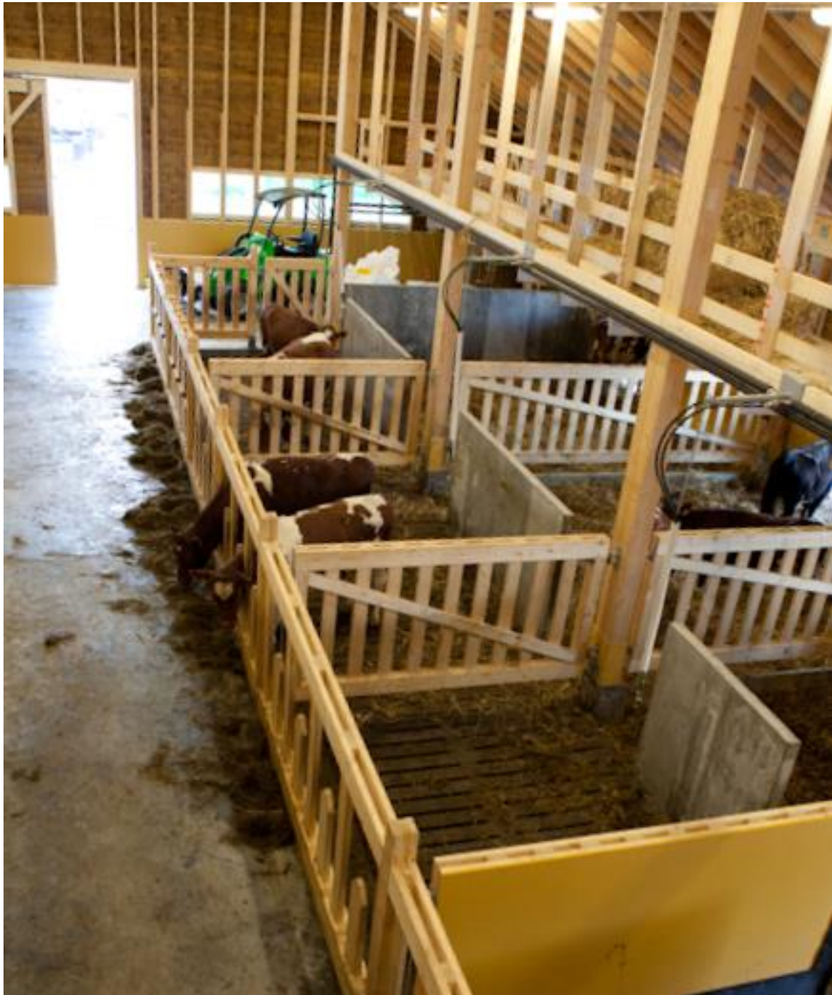
Bilde 5 Ungdyravdelingen på gård 2. Fjøsen er bygd med innredning av tre. Foto: Martha Ebbesvik.
