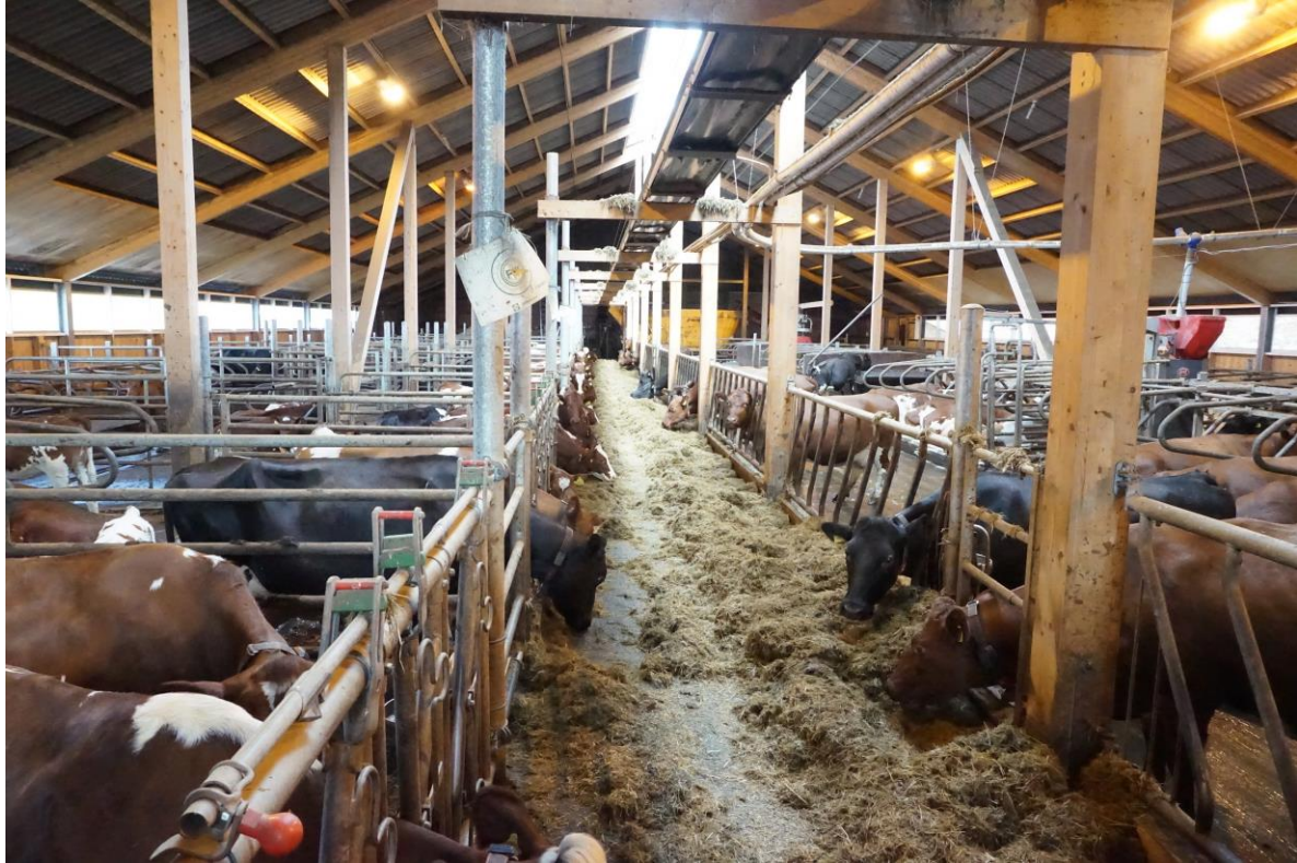
Bilde 4. Fjøsene på gård 1 har naturlig lys fra mønet i taket og naturlig ventilasjon med justerbare gardiner i veggene. Foto: Sissel Hansen.
