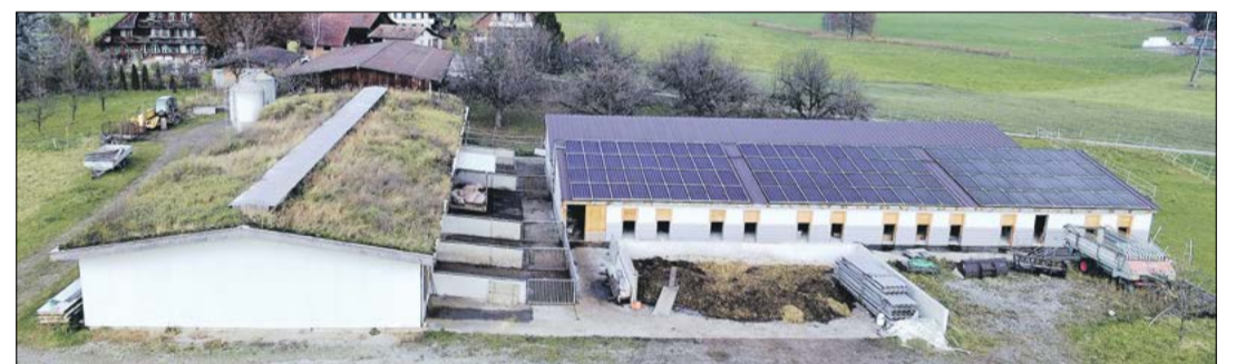
Der Betrieb Rubi mit dem neuen Abferkelstall und der darauf gebauten Photovoltaikanlage.
