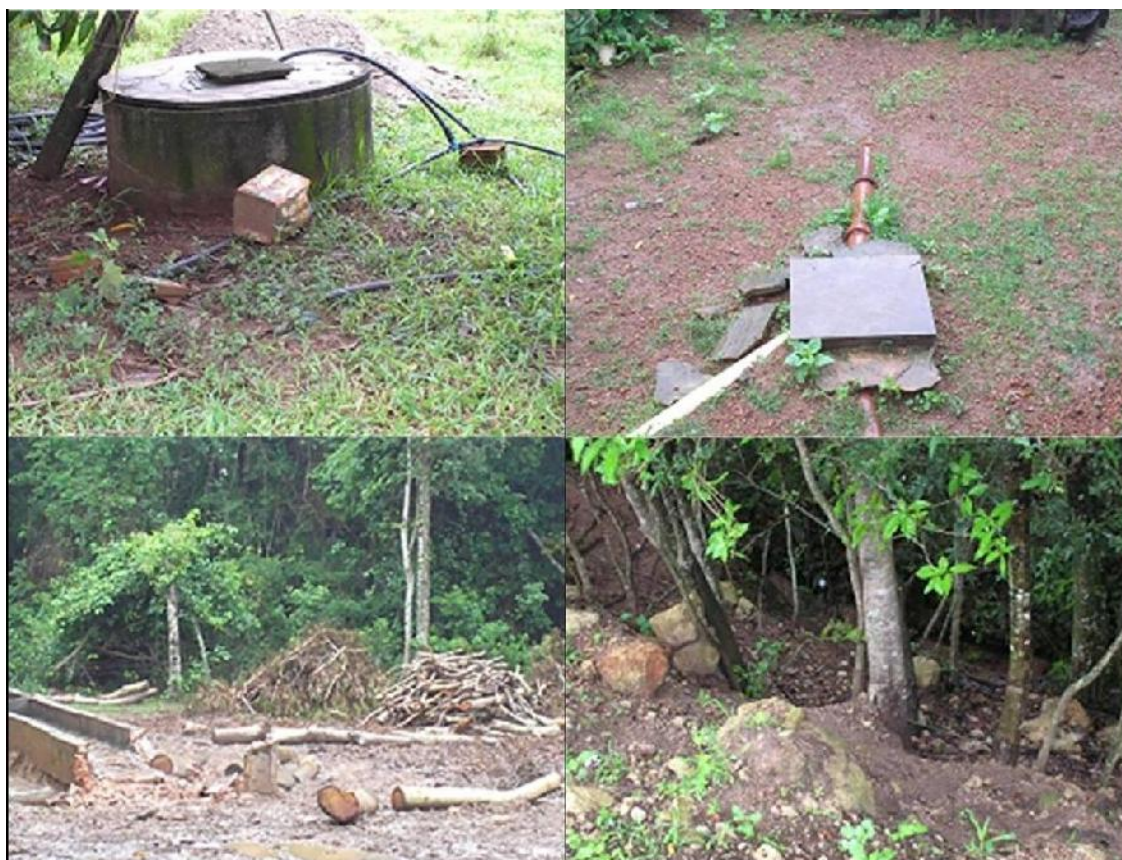
Figura 3 – Poços freáticos para captação de água para consumo doméstico, fossas sépticas expostas, desmatamento e erosão.
