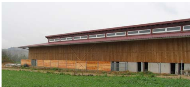
Abb. 2: Stallansicht von Osten (Bauphase)
