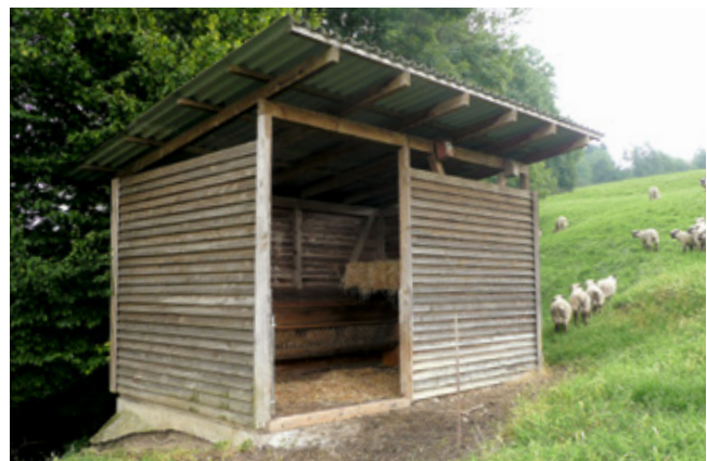
Mit Tiefstreu und gegen Sickersäfte dichten Seitenrändern eignet sich dieser Stall im Winter auch für Rinder. Bild: Landwirtschaft Kanton AG
