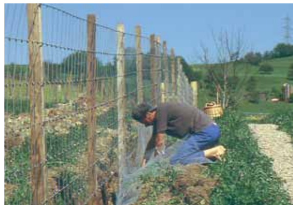
Instalace ochranného pletiva podél oplocení.
