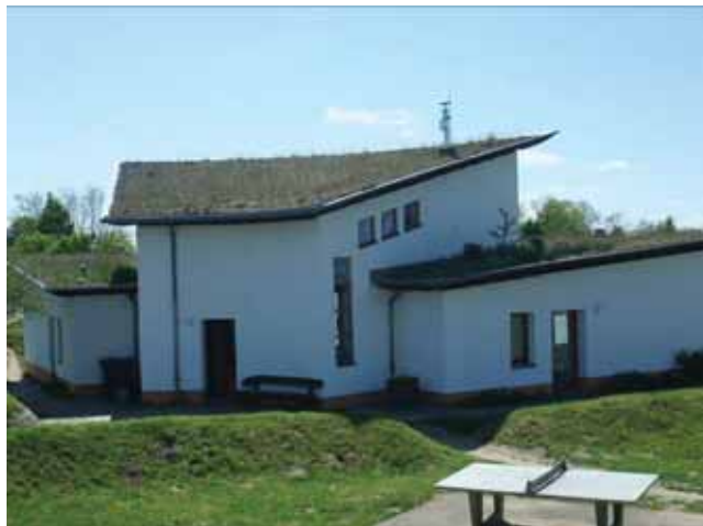
Wohngruppenhaus mit Dachbegrünung
