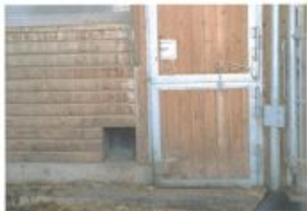
Auslaufzugang: links Ferkelschlupf, rechts zweigeteilte Tür, unten mit Schnauzengriff für die Sau
