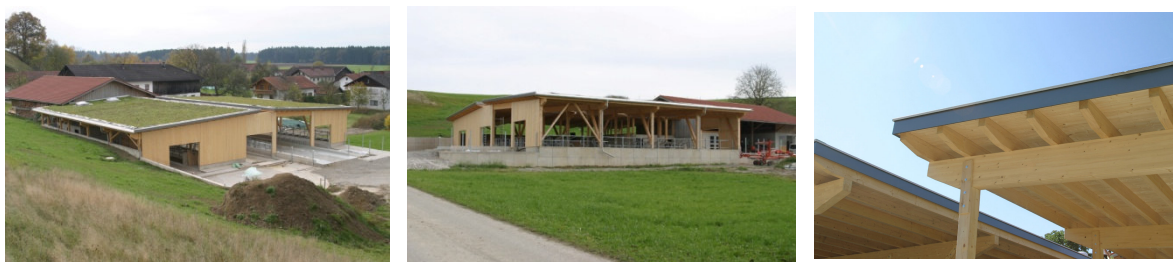
Abb. 5: Ansichten Stall von Nordosten, Nordwesten und Dachdetail
