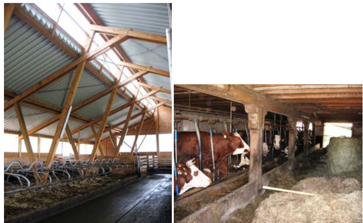
Stallumbau bzw. Stallneubau zum Laufstall
